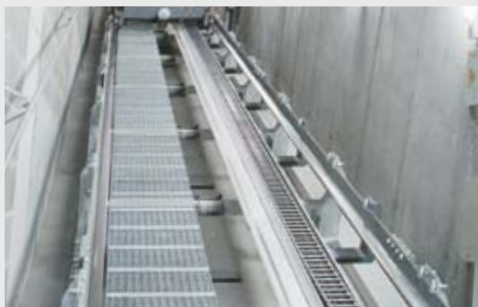
Schacht mit Steg für Wartungsarbeiten
